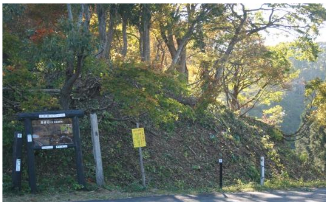
整備後の道路脇の山斜面
